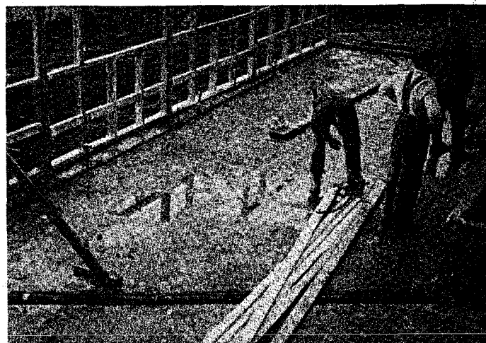
Bild 10. Värme, vatten och avloppsledningar i enplansvilla.
