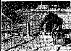
Komprimeringskontrol af jordtyld.
