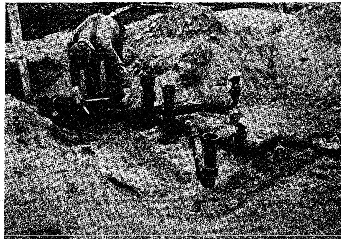
Bild 8. Anslutning till servisledning av förtillverkade avloppsledningar.
