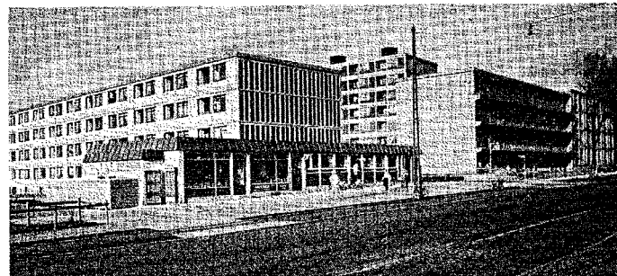
Fig. 4. Hareskovvej. Sydface opbygget af rumstore elementer med udvendig bærende skive.
